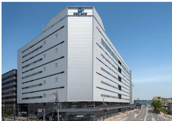
外観:7F 建ての倉庫を活用したオフィス
